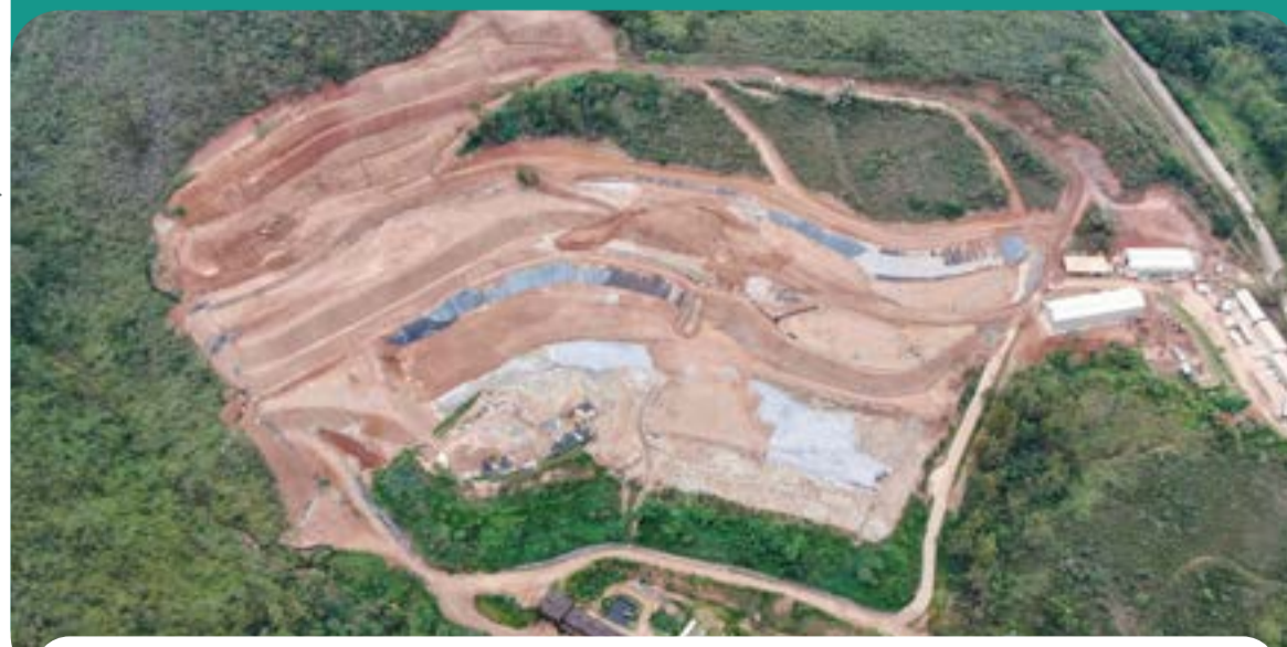
Intervenções no aterro municipal vão melhorar a destinação de resíduos sólidos
