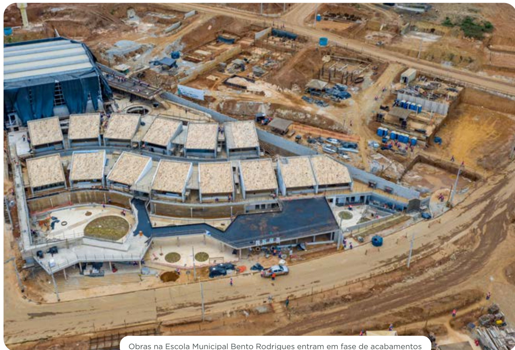
Obras na Escola Municipal Bento Rodrigues entram em fase de acabamentos
