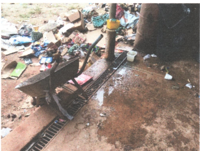
Foto 9: Dispositivo de drenagem da área de triagem.
