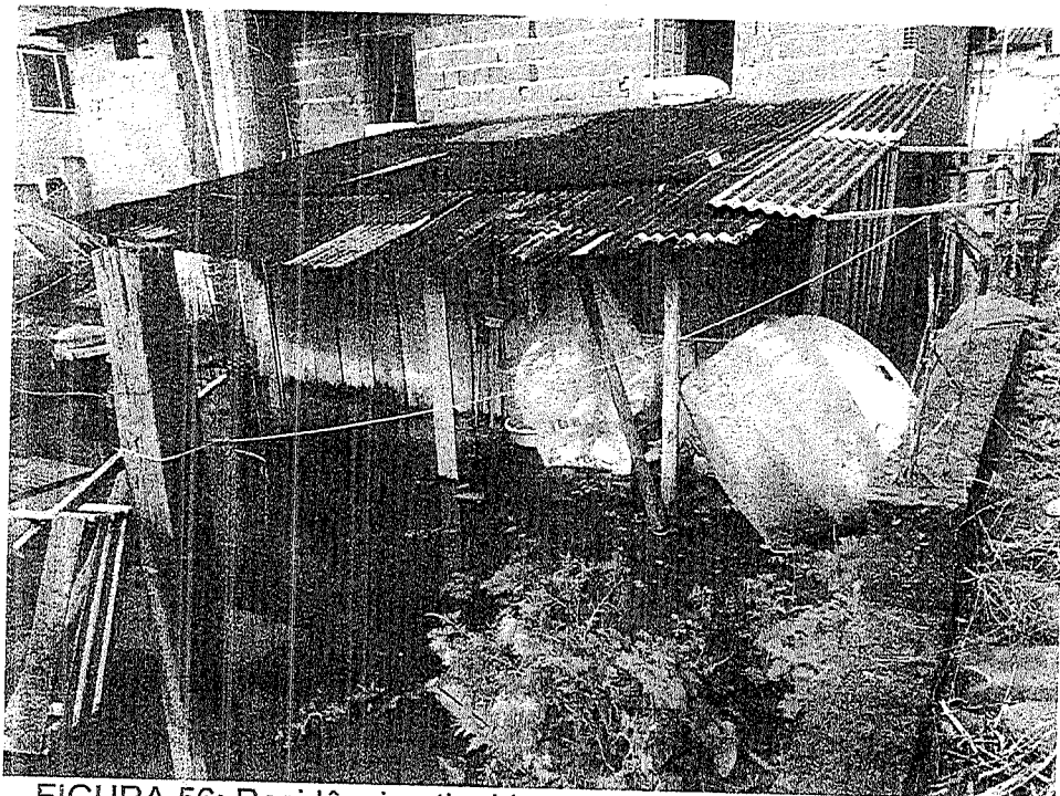
FIGURA 56: Residência atingida pela cheia da Lagoa Juparanã.
