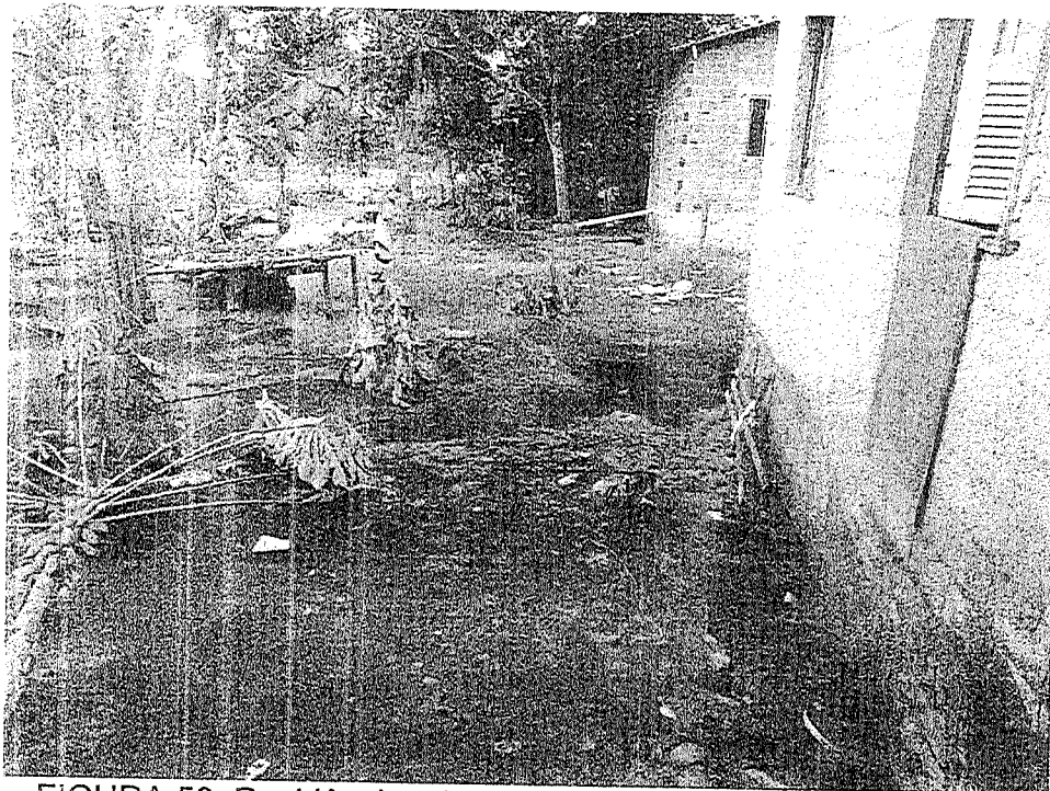
FIGURA 53: Residência atingida pela cheia da Lagoa Juparanã.
