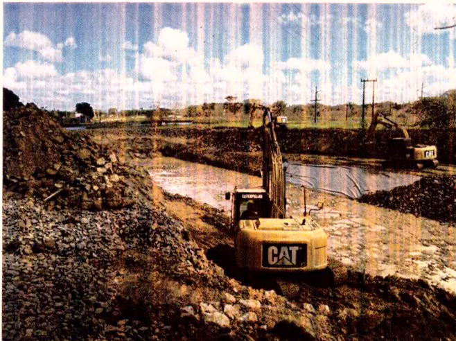
Foto 1: Construção do canal na Lagoa Juparanã, Linhares/ES
