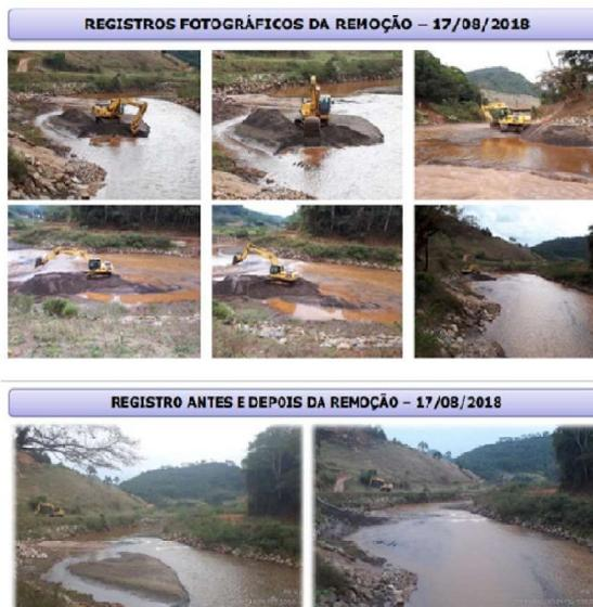
**Figuras 1A e 1B:** Imagens do processo de retirada de rejeito constante do Relatório nº 13, da Auditoria Técnica independente do Ministério Público do Estado de Minas Gerais – AECOM.
