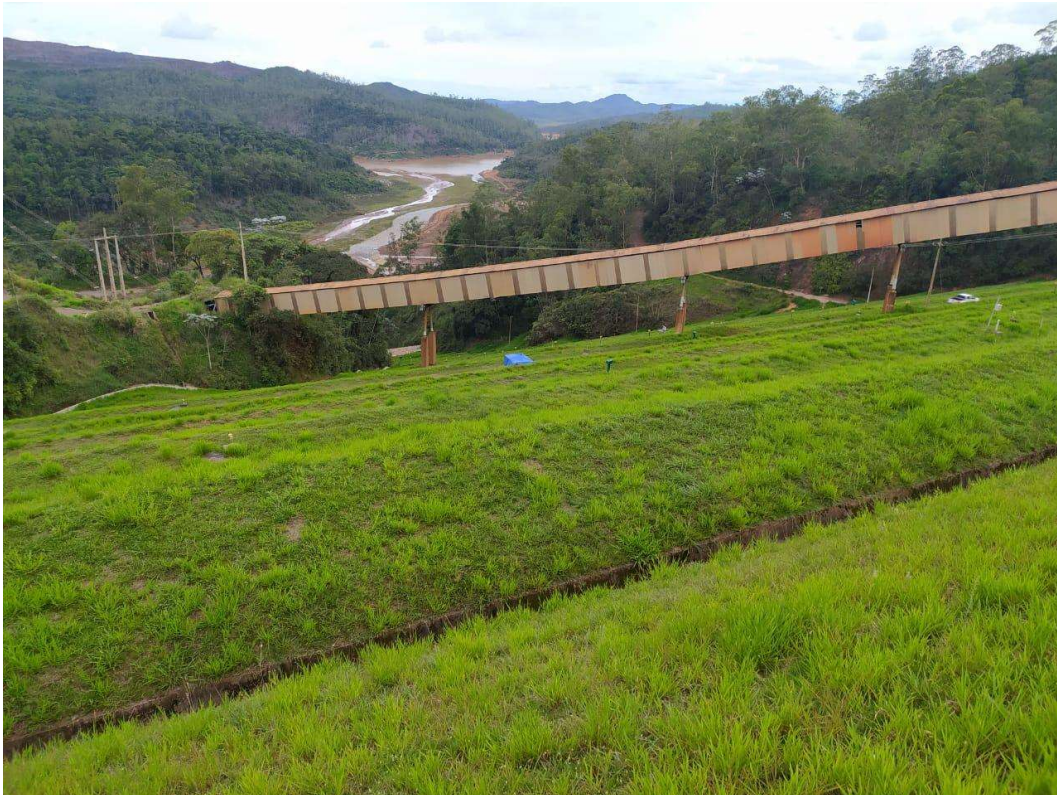
Figura 2b: Talude de jusante da Barragem de Germano
