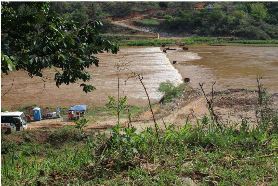
Figura 7a: Barramento A
