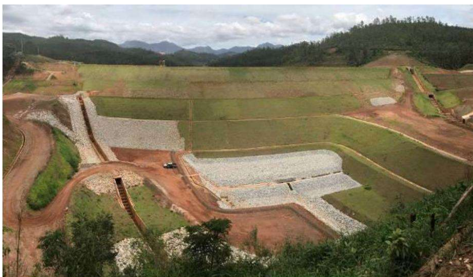
Figura 4b: Talude de Jusante da Barragem de Nova Santarém
