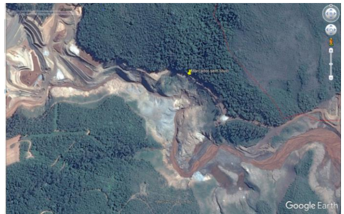
Figura 11: Situação da garganta do Trecho 3 em 2018
