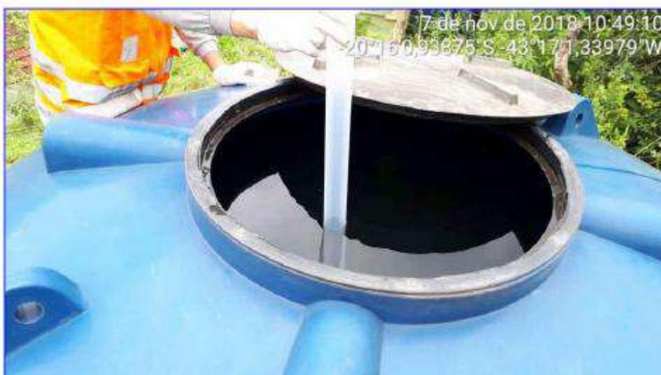
Amostragem de água de abastecimento diretamente em caixa d'água.
