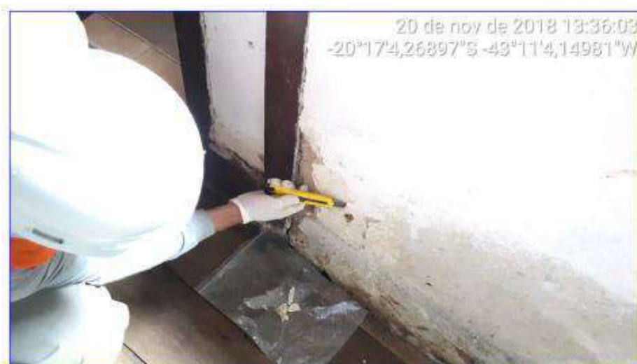
Foto 8 - Registro fotográfico de amostragem de raspagem de alvenaria
