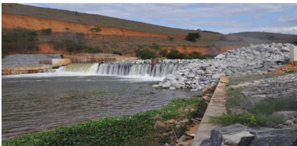
Figura 27 - Barramento construído para retenção da lama.
