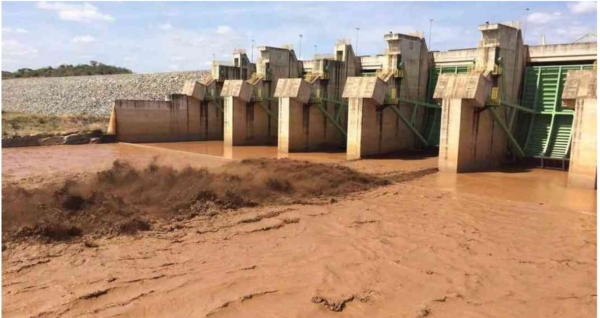
Figura 23 – Momento da passagem da onda de lama pelo vertedouro da UHE de Baguari
