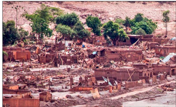
Figura 1. Bento Rodrigues após a passagem dos rejeitos. Foto: Guilherme Weimann/MAB (2017). Fonte: Viana (2017).
