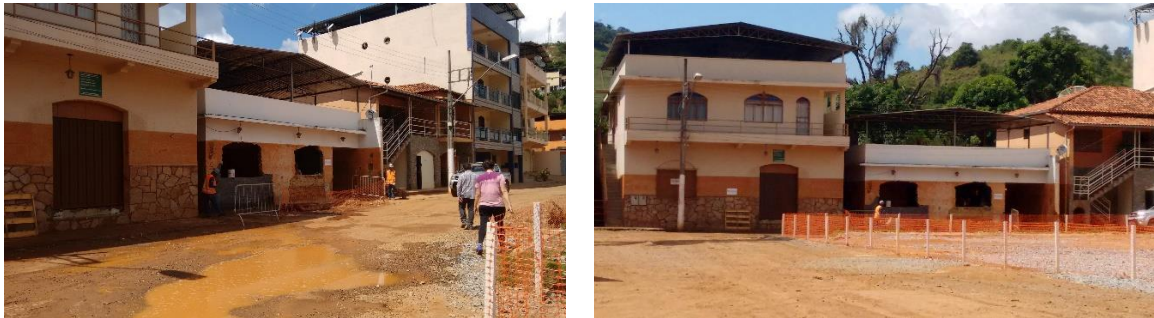
Figura 31 – Centro de Barra Longa – Marca da lama nas paredes Legenda: Fotografia: autoral, 24/04/2016
