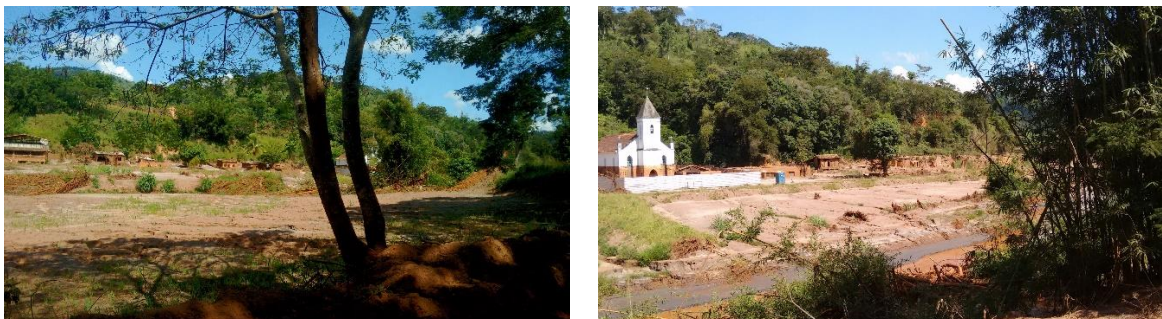
Figura 32 – Comunidade de Gesteira, Barra Longa. Igreja e casas destruídas na margem esquerda pelos rejeitos Legenda: Fotografia: autoral, 24/04/2016
