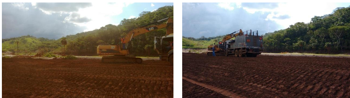
Figura 34 – Zona rural sendo reparada – máquinas trabalhando
