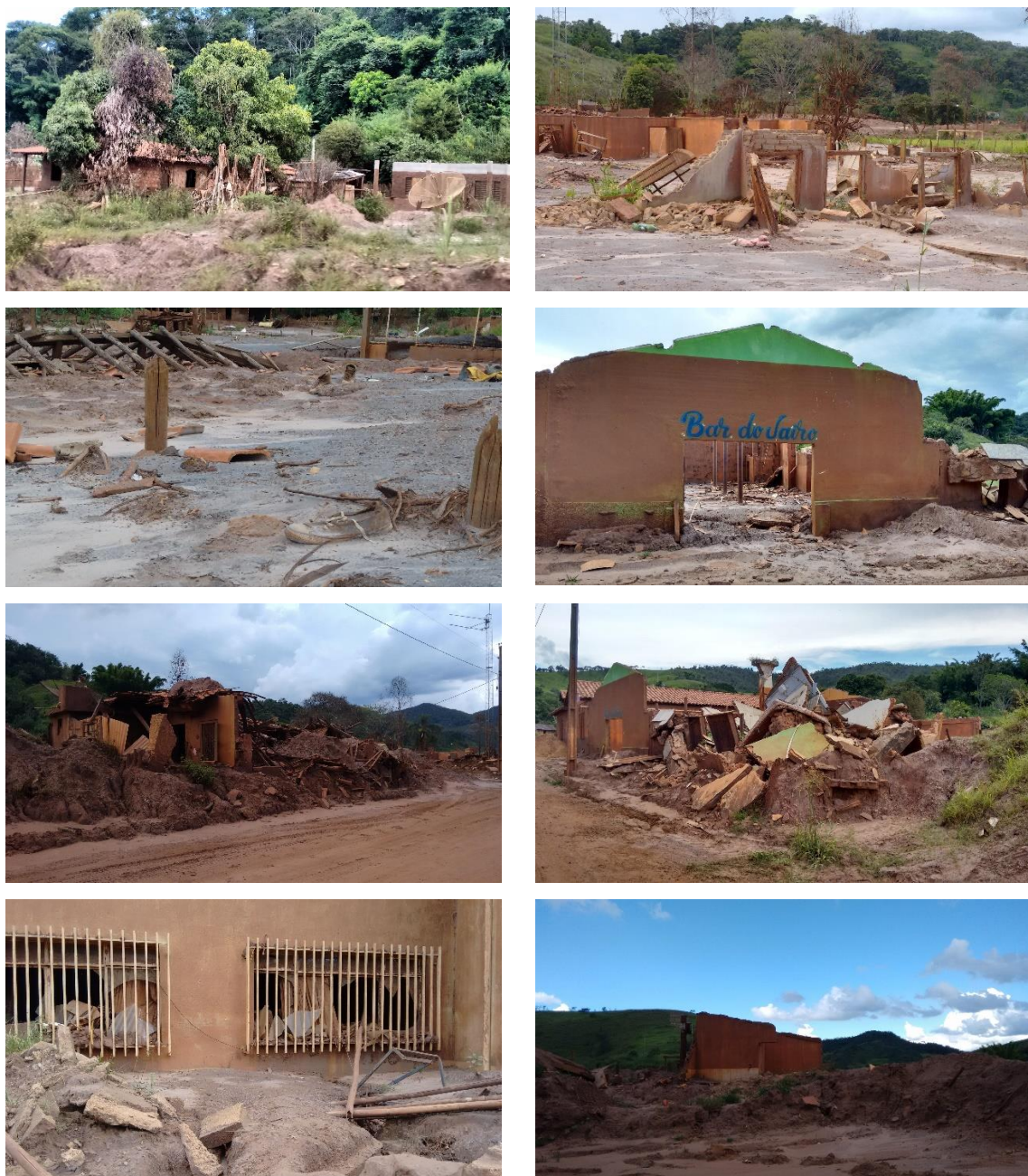
Figura 35 – Comunidade de Paracatu, edificações destruídas pelo mar de lama
