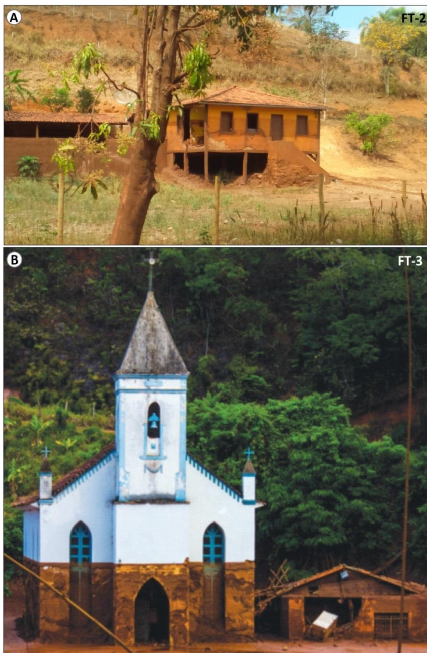
Fig.7. (A) FT-2 (setembro, 2016): Residência em zona rural destruída pela avalanche de lama na região de Paracatu de baixoFonte: Acervo pessoal. (B) FT-3: Exemplo de dano ao patrimônio cultural: capela de Barra Longa. Fonte: Sánchez et al. (2019).
