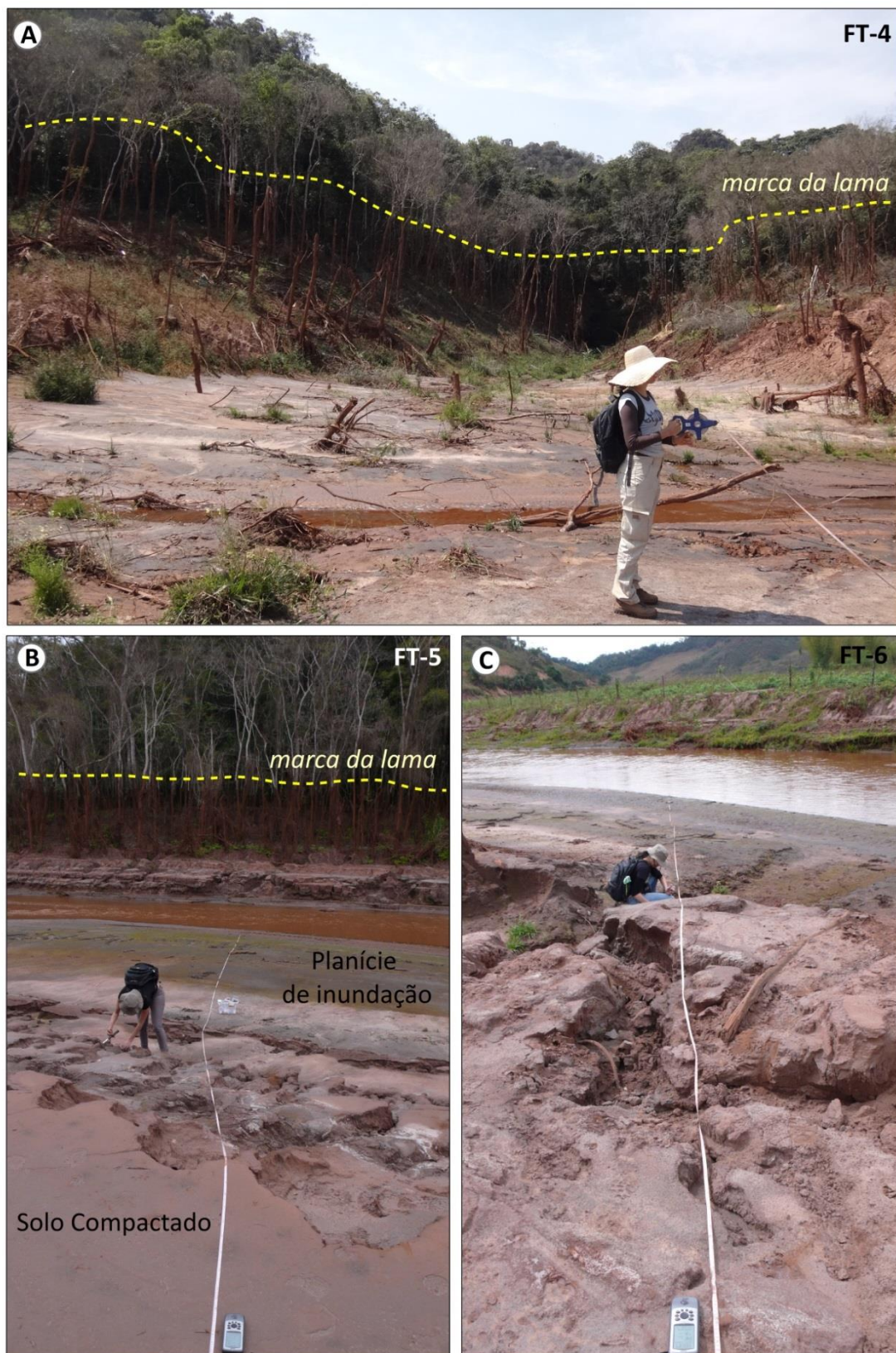
Fig.9. Áreas atingidas pela lama mostrando os danos ao solo e à vegetação. (A) Região de Bento Rodrigues, onde a avalanche arrancou grande volume de árvores. (B e C) Margens do rio Gualaxo do Norte, na região de Paracatu de Baixo. Ressalta-se o solo compactado com ausência de vegetação e matéria orgânica, além de locais caracterizados por ravinas e sulcos erosivos. Fotos FT-4 a FT-6 obtidas no dia 14 de setembro de 2016 (Fonte: Acervo pessoal).
