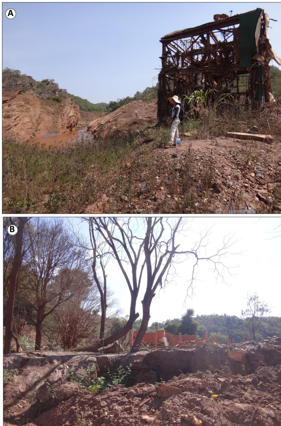
Fig.4. (A) Foto obtida em 14 de setembro de 2016. Galpão as margens do rio Gualaxo do Norte, que foi totalmente destruído pela avalanche. (B) Foto obtida em 13 de setembro de 2016. Vegetação de grande porte com elevado nível de stress, ao lado de residência totalmente destruída. Fonte: Acervo Pessoal.
