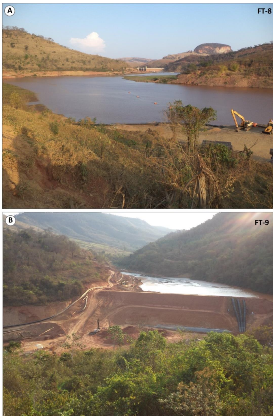
Fig.11. (A) Barragem da UHRN, mostrando a área considerada prioritária para retirada de rejeito. (B) Vista para um dos diques construídos na Fazenda Floresta, que compreende parte do processo de remoção do rejeito do reservatório. Fotos FT-8 e FT-9 obtidas em 18 de setembro de 2016 (Fonte: Acervo pessoal).
