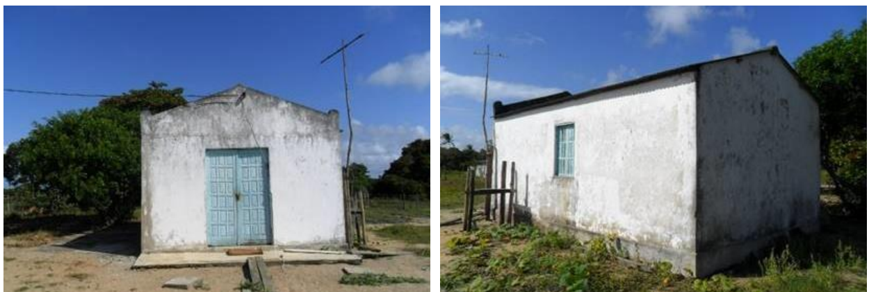
FOTO 65. Igreja de Nossa Senhora Aparecida.
