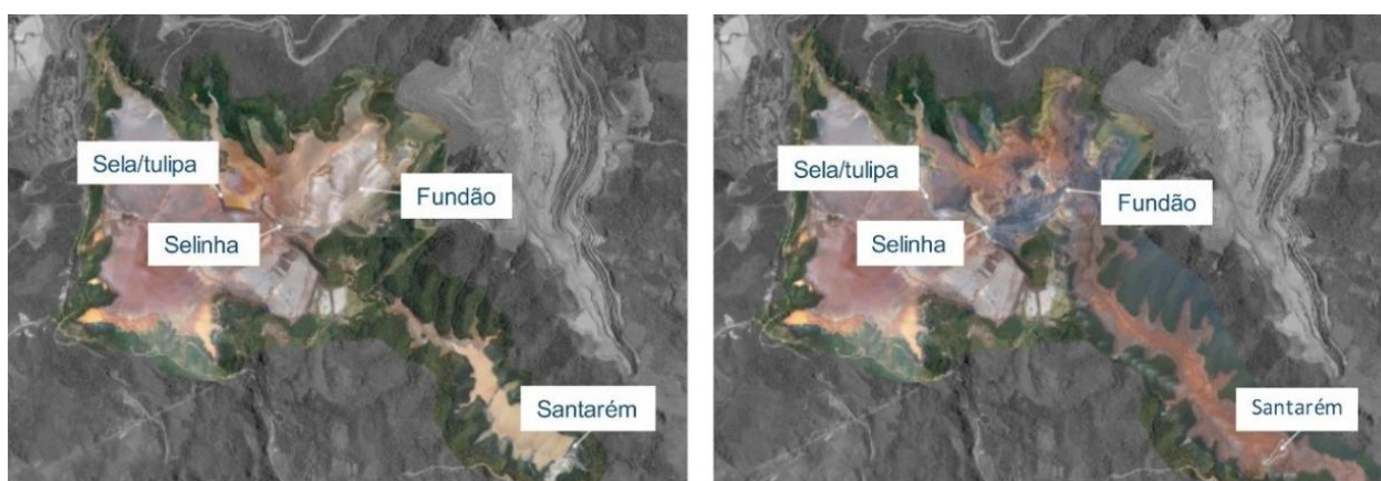
FIGURA 1. Imagem aérea das barragens pertencentes ao Complexo Minerário de Germano
