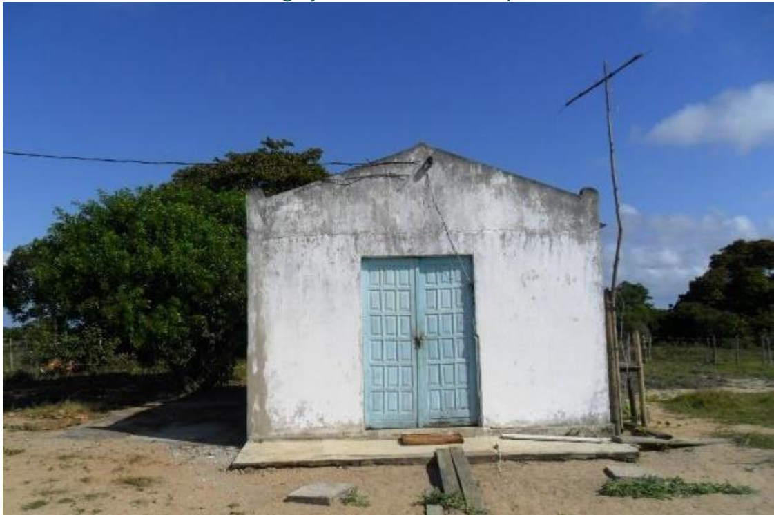
FOTO 46. Igreja de Nossa Senhora Aparecida
