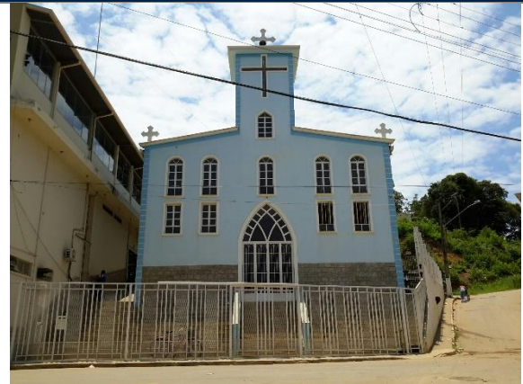
Igreja Nossa Senhora do Perpétuo Socorro
