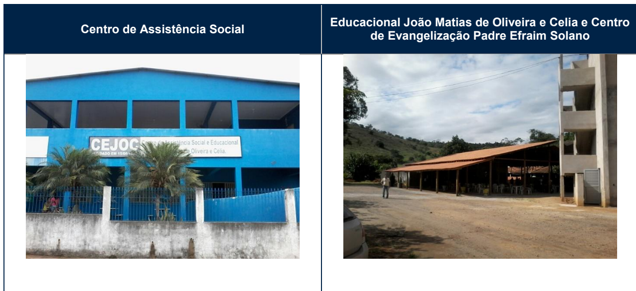
Figura 10 Centro de Assistência Social e Centro de Evangelização Padre Efraim Solano
